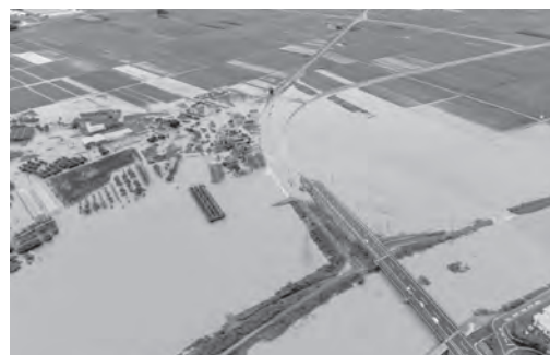
▲白水川堤防決壊による浸水被害（7月29日）
