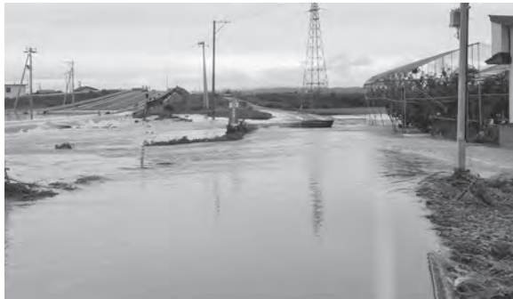
▲決壊地点から押し寄せる濁流（長瀬地区岡島地区）
