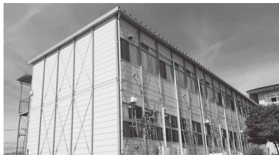
▲教室が不足する神町中学校 仮設校舎
