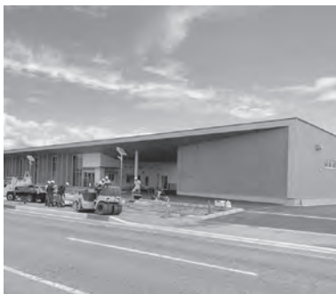
▲完成間近の「東根市西部防災センター」
