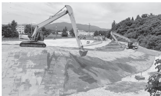
▲整備が進む（仮称）大森山クロスカントリーコース
