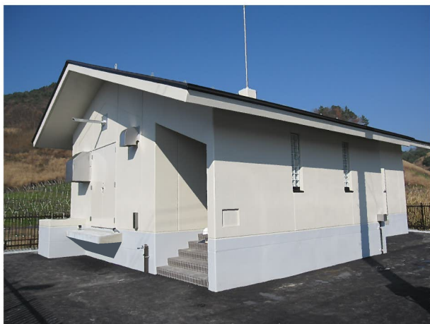
高岡中継ポンプ場
