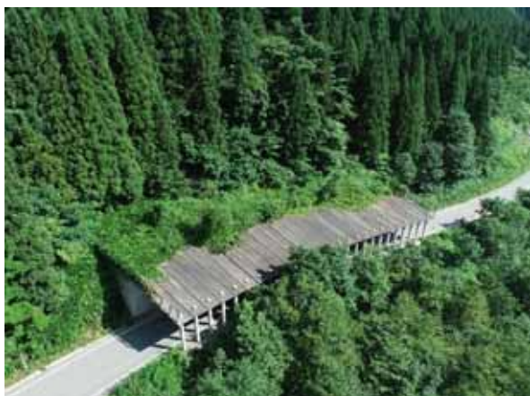
市道柳沢線 坂下山スノーシェッド
