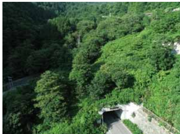
市道柳沢線 坂下山トンネル
