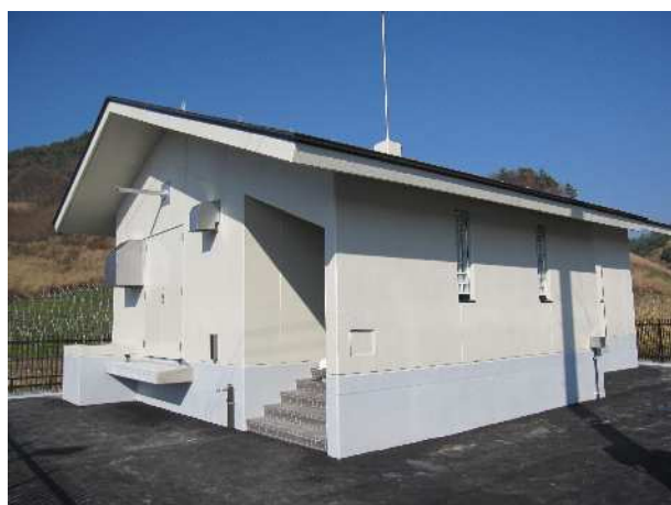
高岡中継ポンプ場
